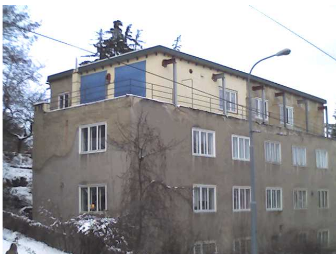
Obr.č.1 stávající fasáda objektu [1]
